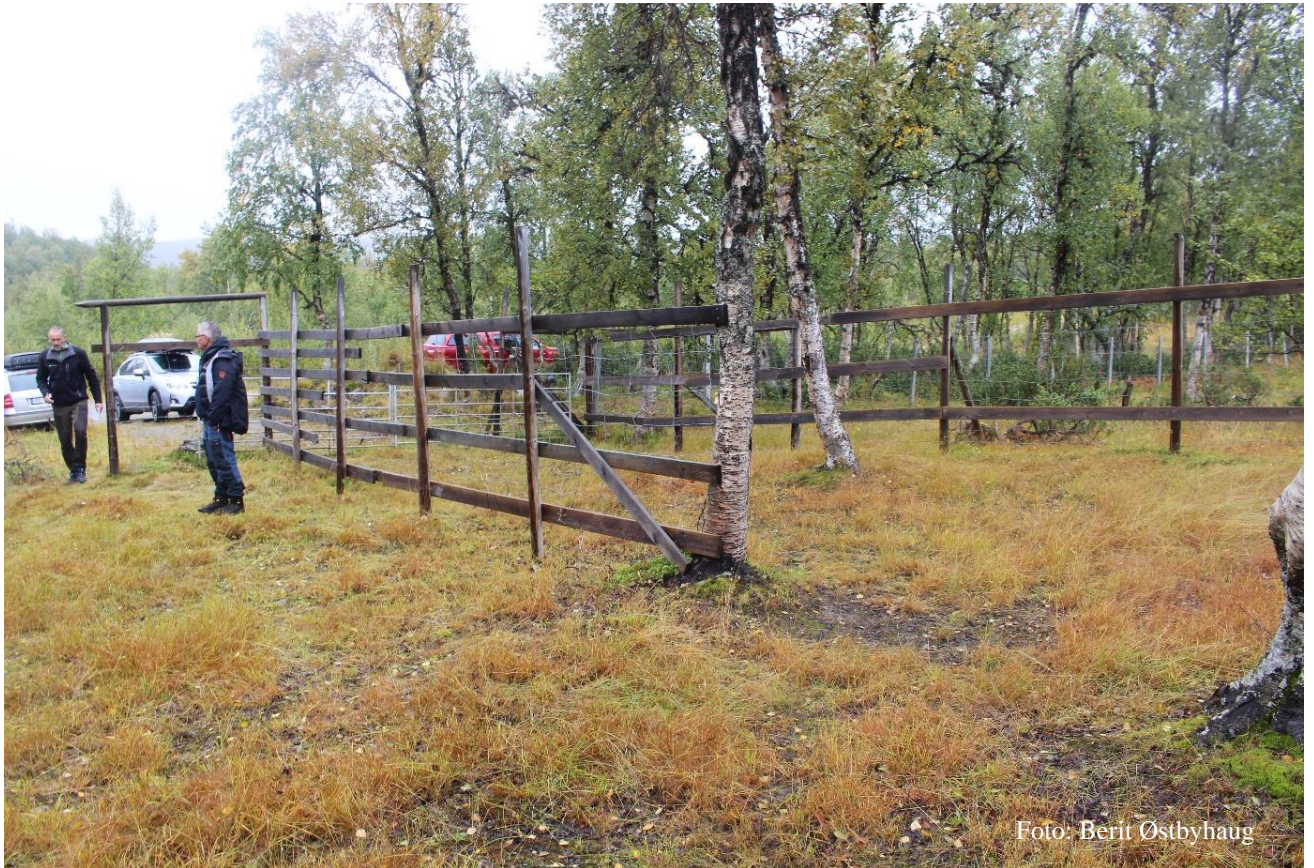
Inngjerding og skilleanlegg i Langvika. Har ikke vært i bruk siden 2018
